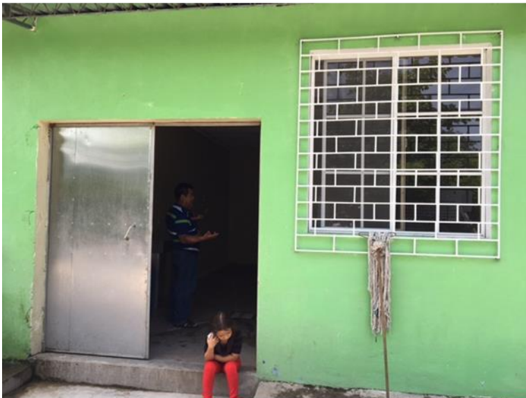
Vista exterior de la adecuación del centro de acopio
